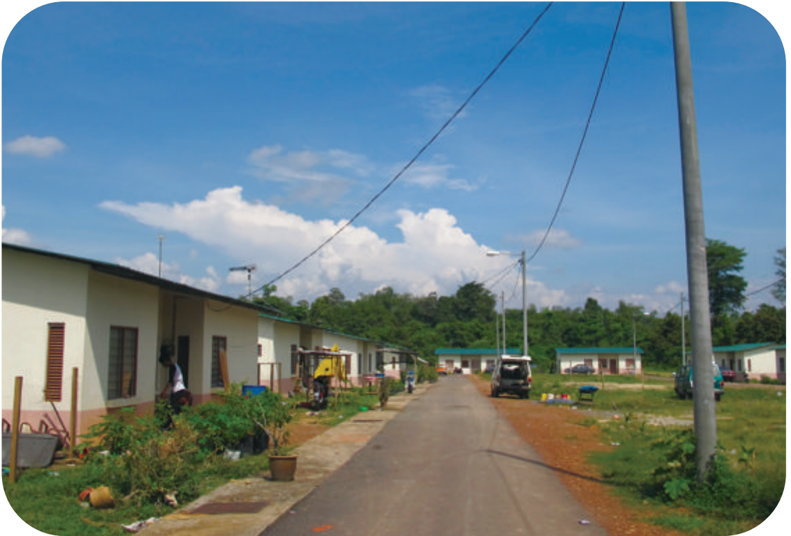
The houses at Kawasan Perumahan Yayasan Sejahtera in Kampung Teluk Melati, Maran, Pahang
